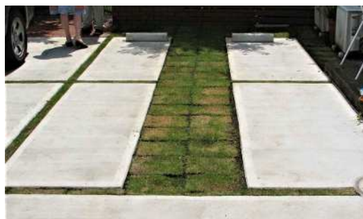
<駐車場緑化事業の施工例>
