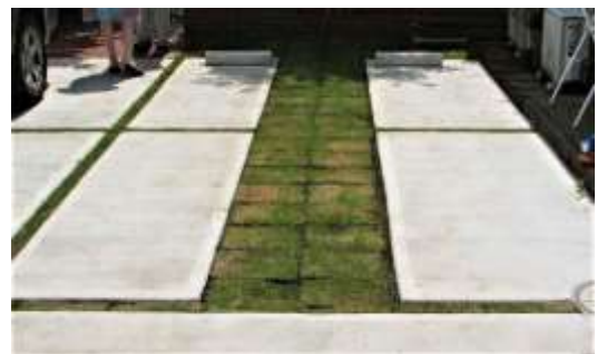
〈駐車場緑化事業の施工例〉
